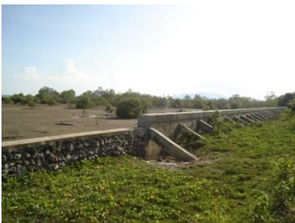
รูปที่ 4-6 กำแพงคอนกรีตเสริมเหล็กป้องกันการกัดเซาะชายหาดด้านที่ติดทะเล หมู่ที่ 2 บ้านคลองประสงค์
