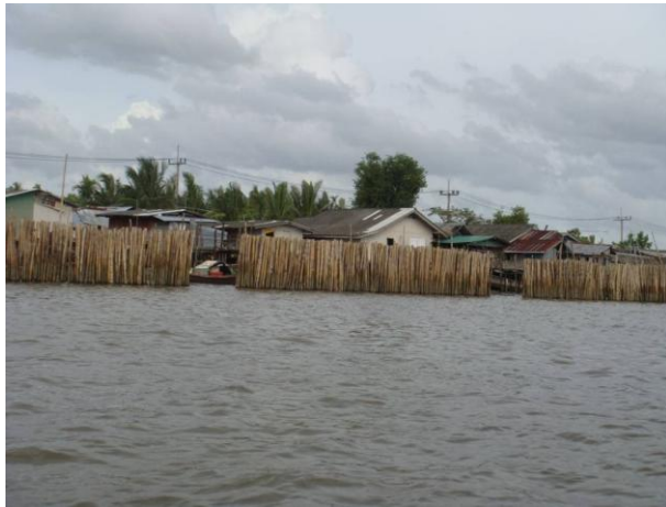
รูปที่ 4-4 กำแพงไม้ไผ่เพื่อชะลอแรงคลื่นและบรรเทาการกัดเซาะชายฝั่งตามแนวชายฝั่งคลอง หมู่ที่ 1 บ้านเกาะกลาง
